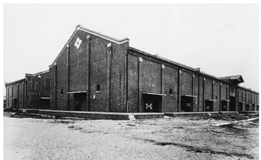
竣工当時（1923 年）の赤レンガ倉庫
