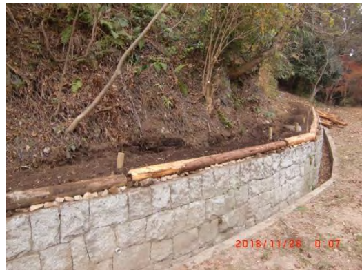
整地して、土砂が溝に落ちないように丸太で
