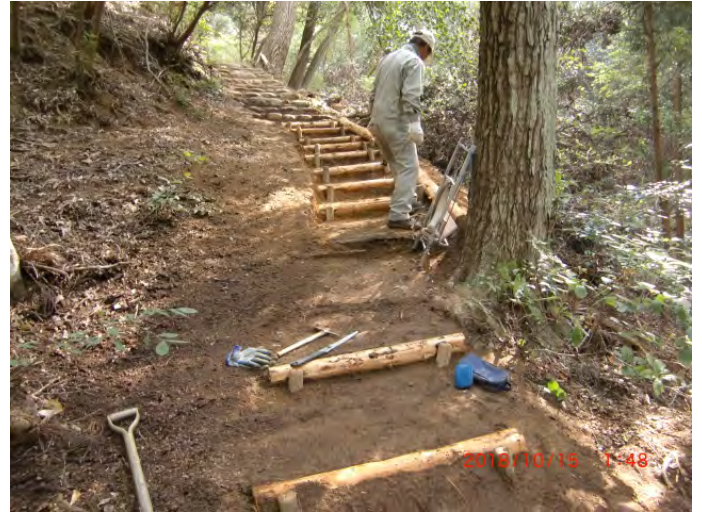
安全第一、滑りそうな坂道を階段にしました
