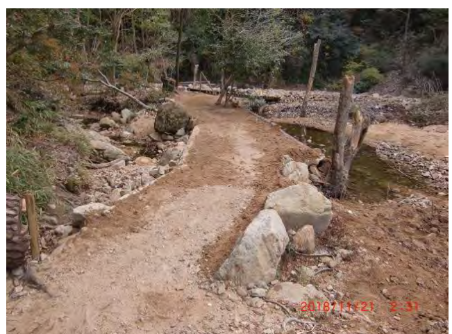
豪雨で増水した流れが道路を破壊して絶えず補修が必要な道路です。
