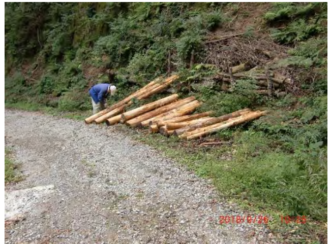
高雄山の間伐材の皮をむいて乾燥させて使用する
