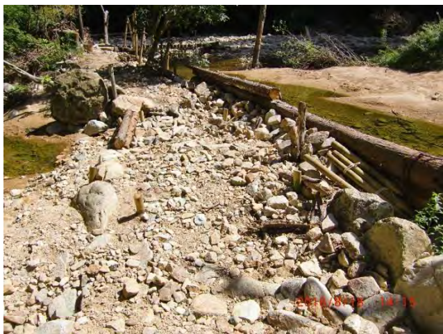
豪雨で増水した流れが道路を破壊して絶えず補修が必要な道路です。
